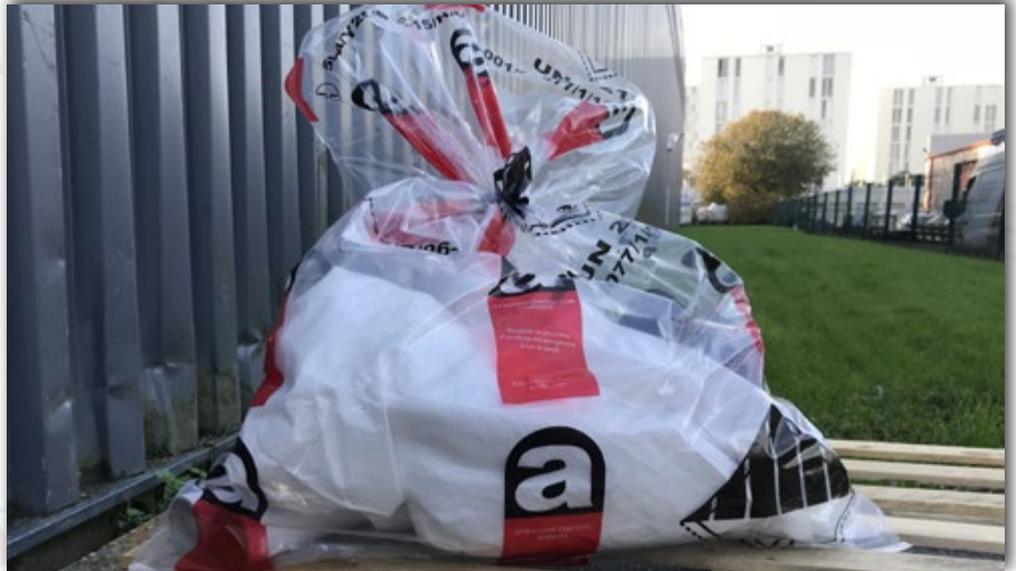
Stockage des EPI souillés par l'amiante dans un sac PE amiante.
